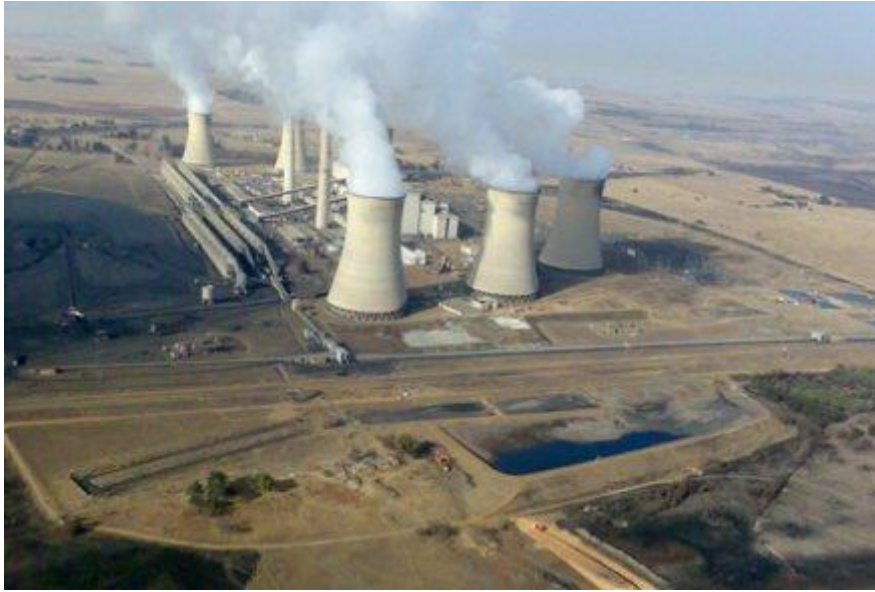
La centrale électrique d'Arnot à Mpumalanga, en Afrique du Sud
